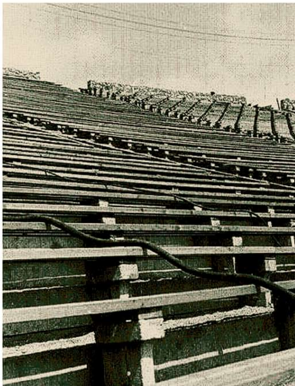
Zbigniew Dłubak udokumentował różne fazy budowy stadionu
