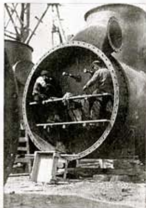
◆ Montaż maszyn. 25 lipca 1929 roku
